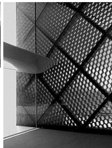
Figura VI: Detalhe do brise-sanduíche – Esquadria composta de coluna estrutural diagonal, com encaixe duplo para fixação de quadros de vidro externo e interno laminado cinza de 10 mm. Os painos de vidro são modulados em 1.600 mm x 1.600 mm.
