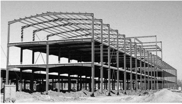
Figura I: Esqueleto estrutural em aço
