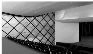
Figura V: Detalhe do auditório – O tratamento acústico da plateia foi trabalhado para o uso da palavra, com tempo de reverberação calculado em torno de 0,75 s, com recomendações especiais para isolamento de ruídos externos nas esquadrias de vidro e no sistema de ar condicionado. Acima do palco existe um plano inclinado.
