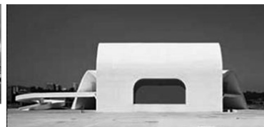
Figura III: Fachada nordeste. Porta revestida com painéis de alumínio, na cor vermelha, que permite abrir o palco para a grande praça.
