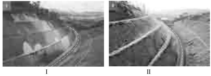
Um trecho rodovia que liga Brasília a Unai, pouco tempo após a sua execução, apresentou deslizamento em partes do lado esquerdo do talude de corte, como indicam as áreas recuperadas mostradas na figura I. Depois de concluída a rodovia, o mesmo talude foi revestido com cobertura vegetal, como mostra a figura II.
