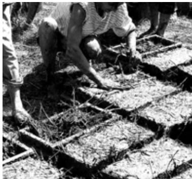
1 – Confeção tradicional de blocos de adobe, nos quais as fibras vegetais reforçam a massa cuja resistência surge mediante a secagem por energia solar.
