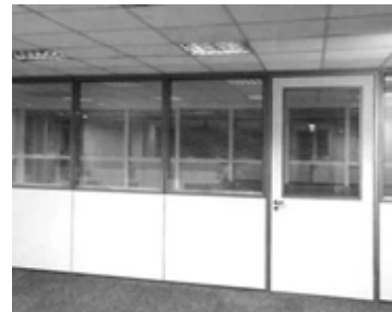
3 – Vedação modulada e industrializada, composta por divisórias removíveis obtidas com alto consumo de energia, mediante uma sequência de passos automatizados em uma linha de produção. Um espaço delimitado por divisórias é “flexível”, quer dizer, as reformas são rápidas, limpas e de baixo consumo de energia.
