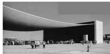
pavilhão de Portugal, Lisboa, 1998, Álvaro Siza
