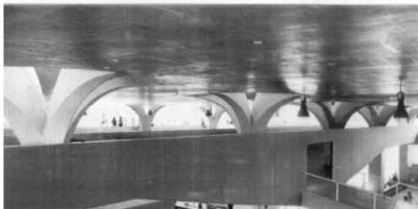
rodoviária de Jaú, 1973, Villanova Artigas
